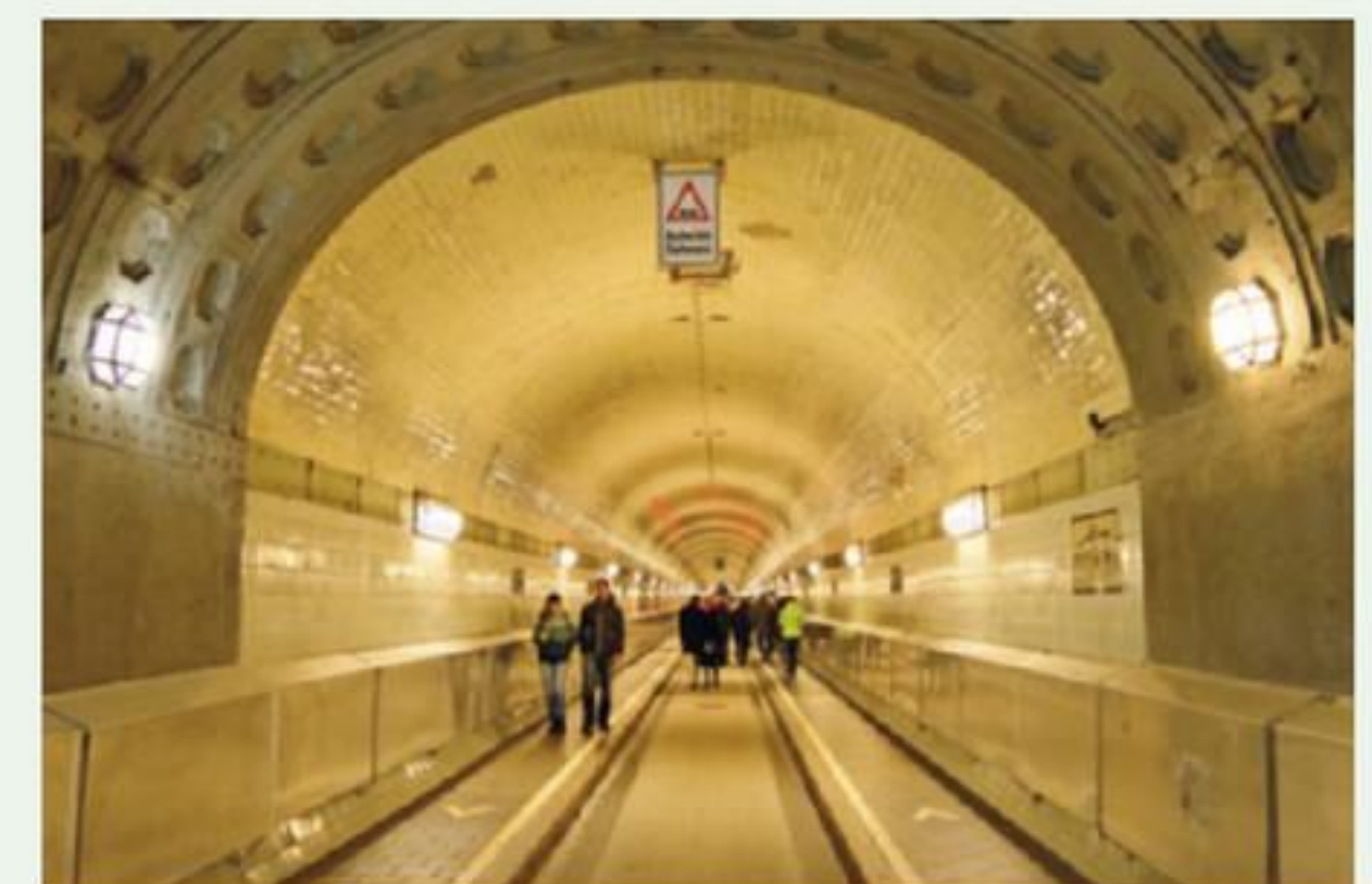
Der Alte Elbtunnel
