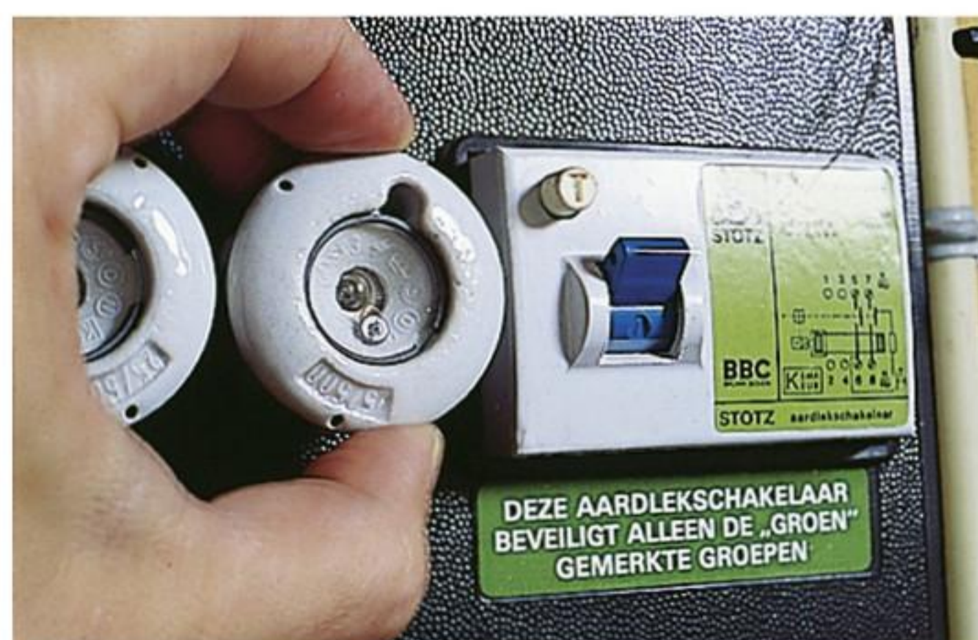
afbeelding 8 Draai de kapotte smeltveiligheid los.
