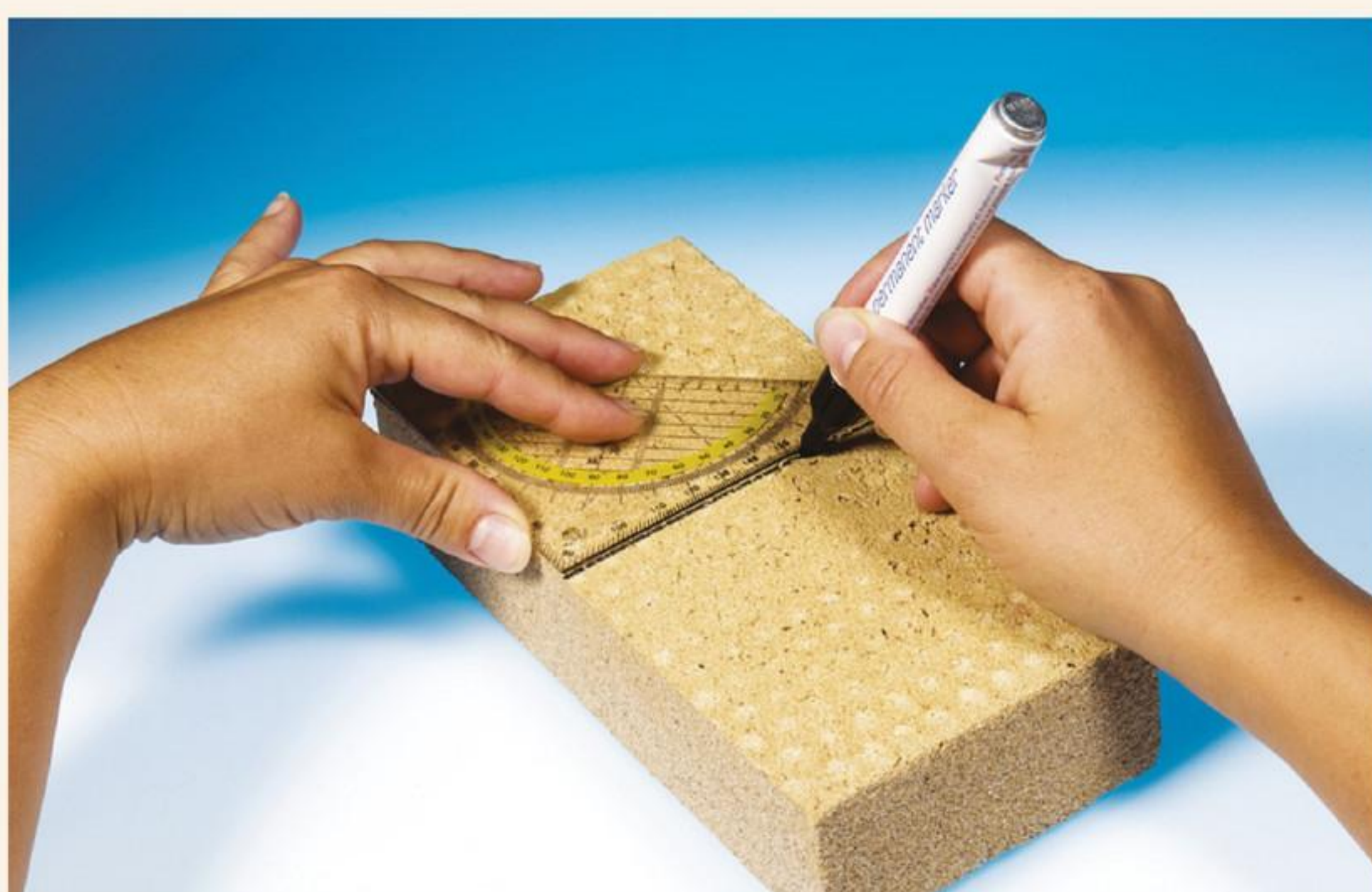
afbeelding 11 Zo zet je de streep op de baksteen.
