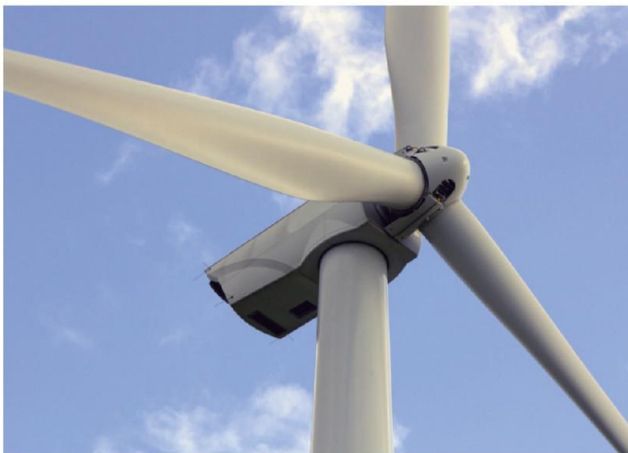
afbeelding 2 Boven in de windmolen zit een generator.
