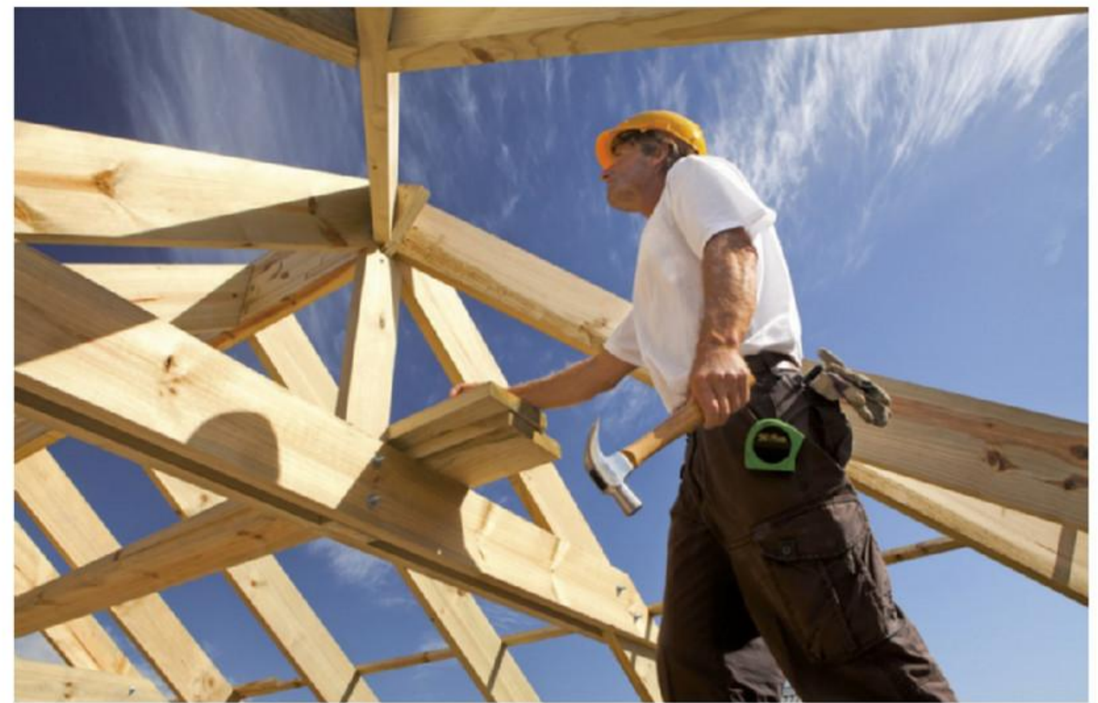
afbeelding 7 Een timmerman maakt de dakconstructie.
