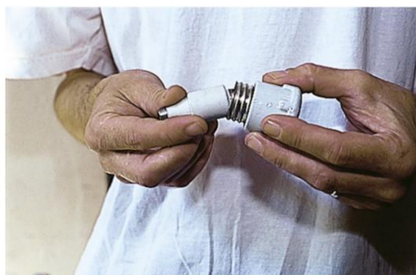
afbeelding 9 Vervang de kapotte smeltveiligheid.
