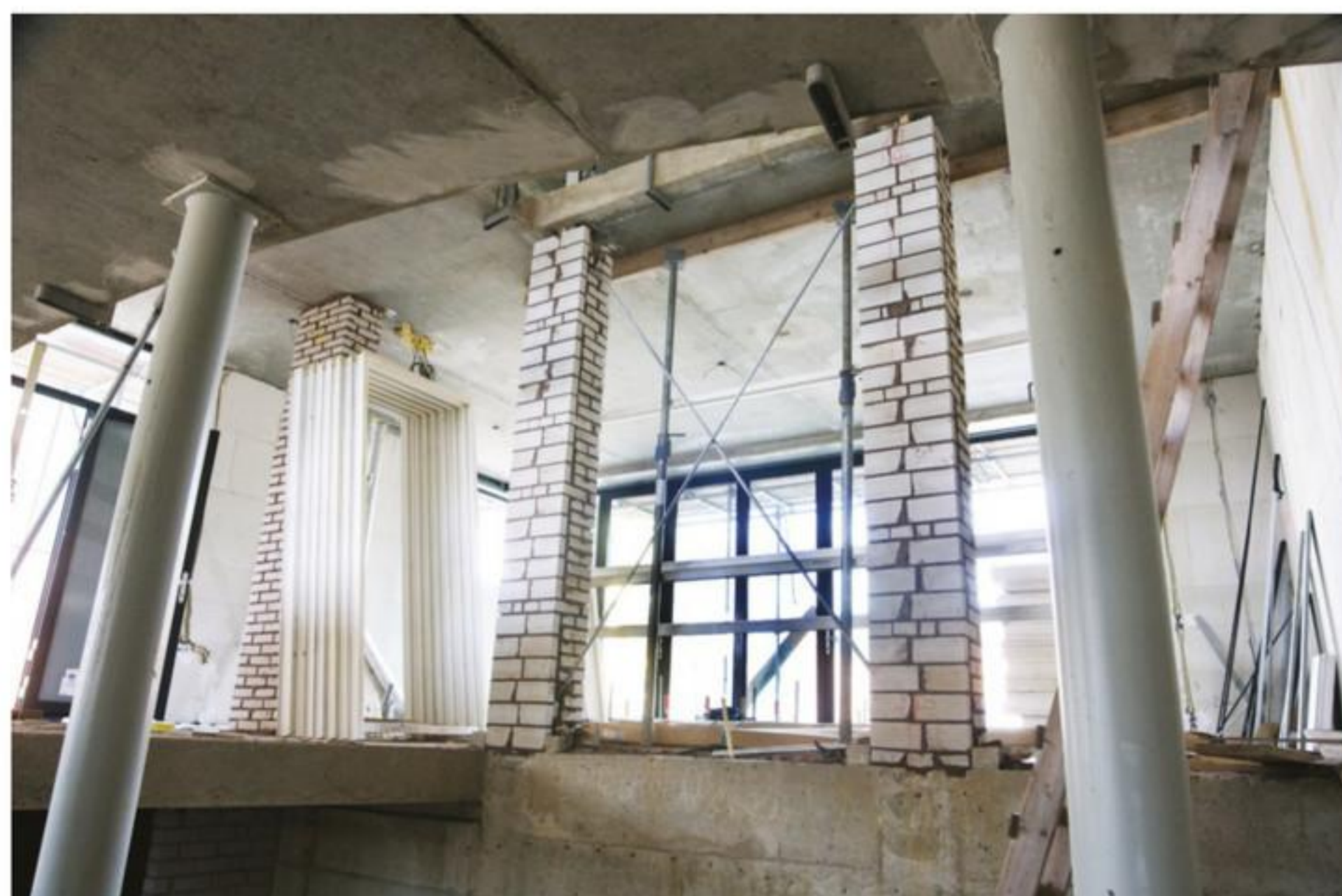
afbeelding 4 Verschillende materialen op de bouwplaats.
