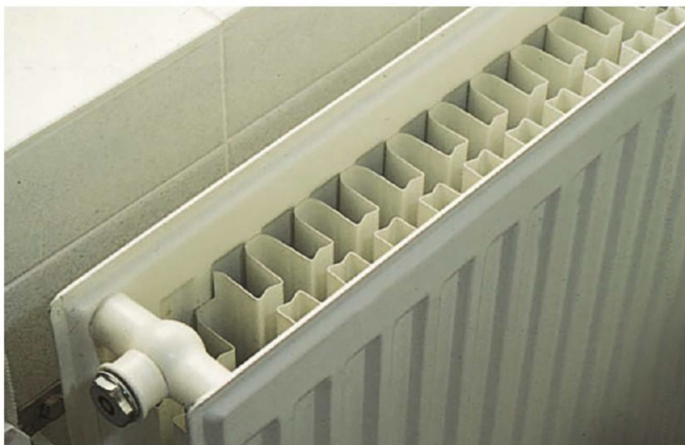
afbeelding 6 Verf beschermt het staal tegen roesten.
