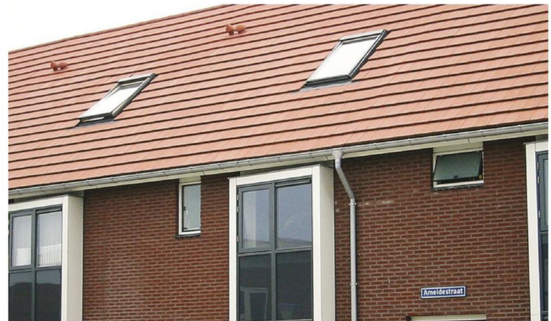
afbeelding 9 De dakpannen zijn gemaakt van poreuze keramiek.
