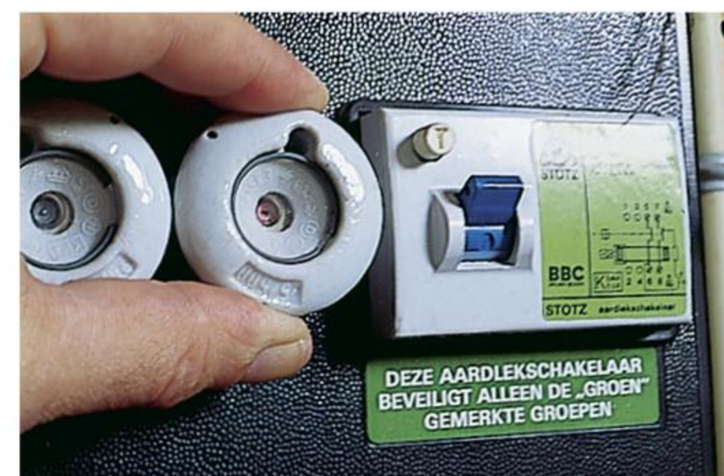
afbeelding 10 Draai de houder weer op zijn plaats.
