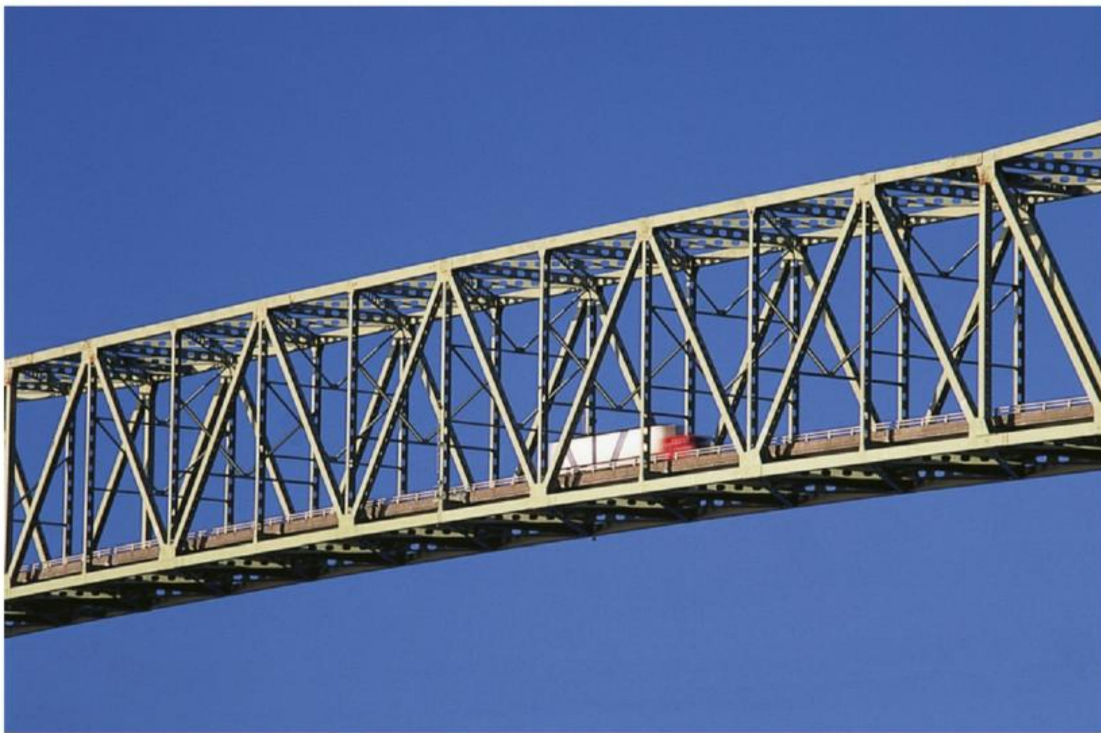
afbeelding 5 De brug is van staal.
