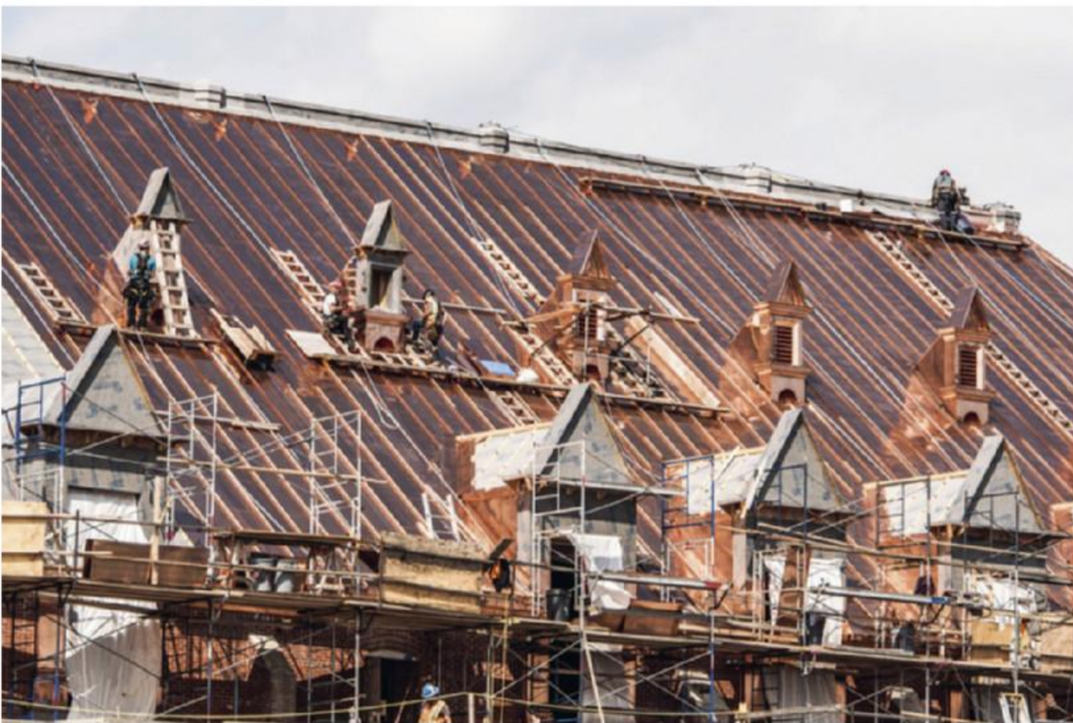
a nieuw koperen dak
