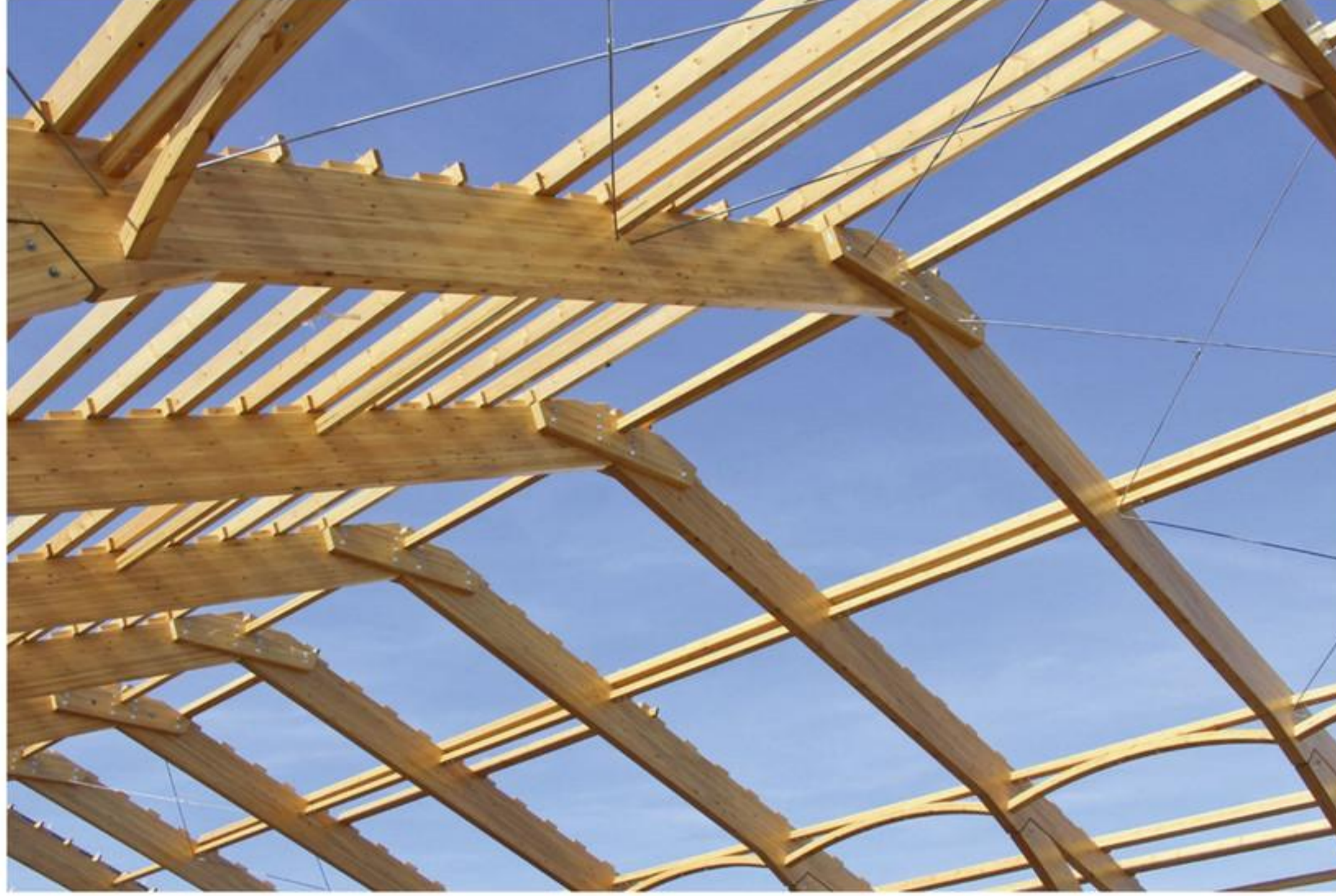
afbeelding 9 Een dakconstructie van hout.
