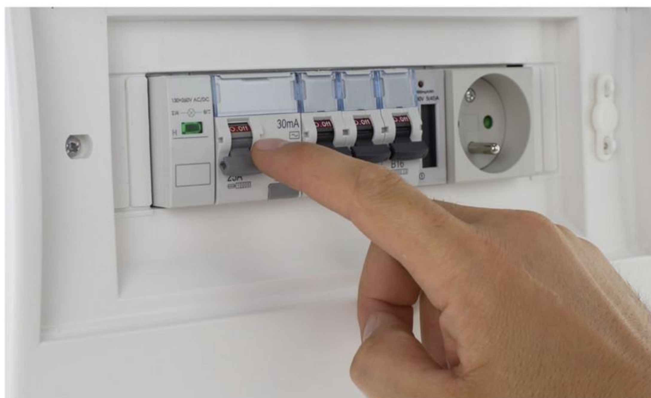
afbeelding 4 Eén aardlekschakelaar voor drie groepen.
