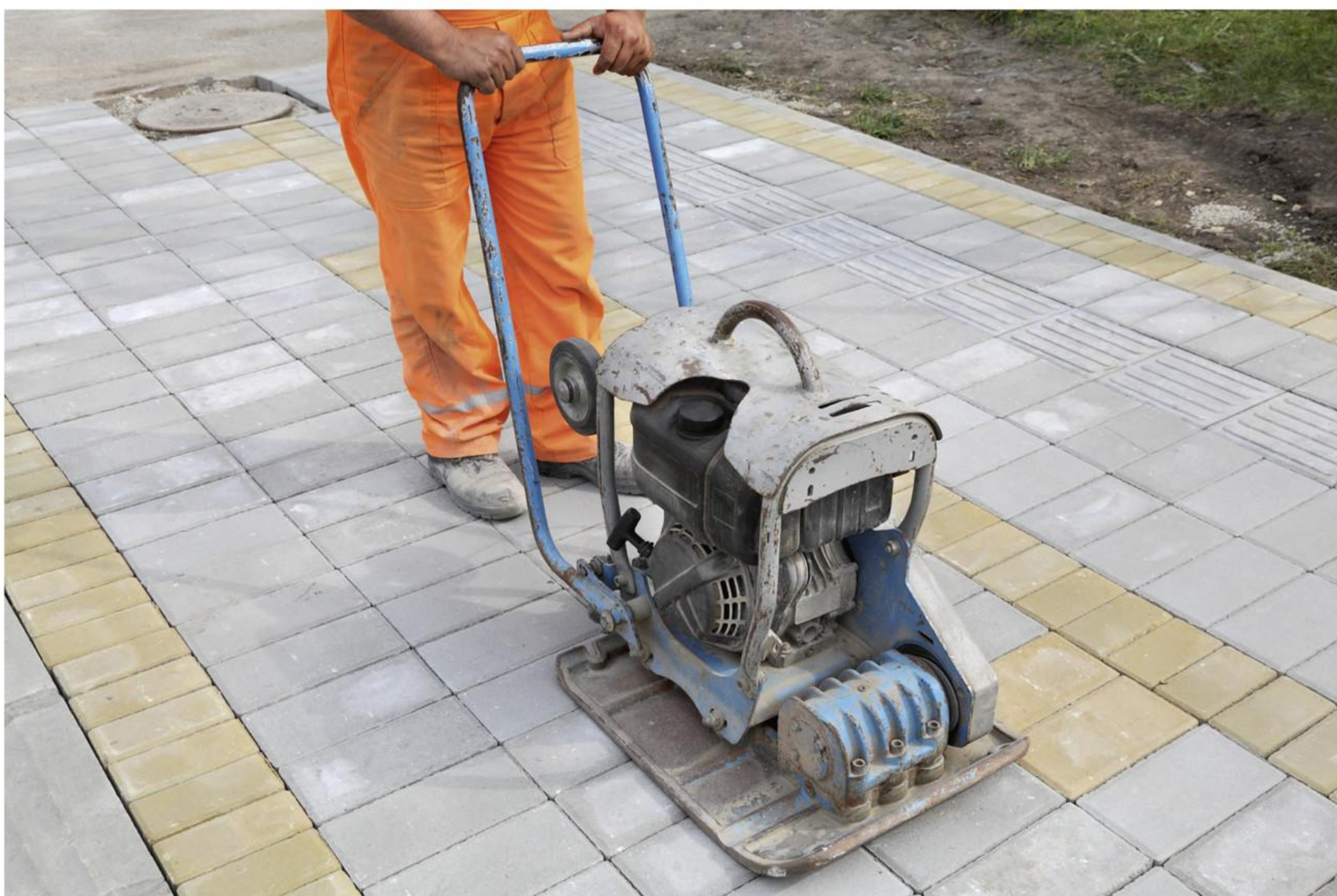
afbeelding 2 Met een trilplaat tril je de stenen vast.
