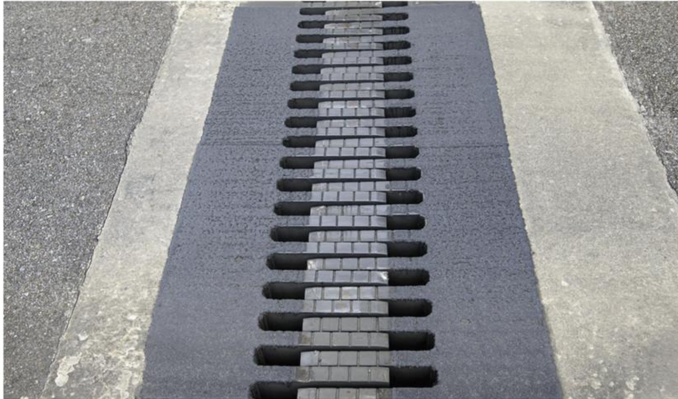
afbeelding 5 Een voegovergang bij een brug.
