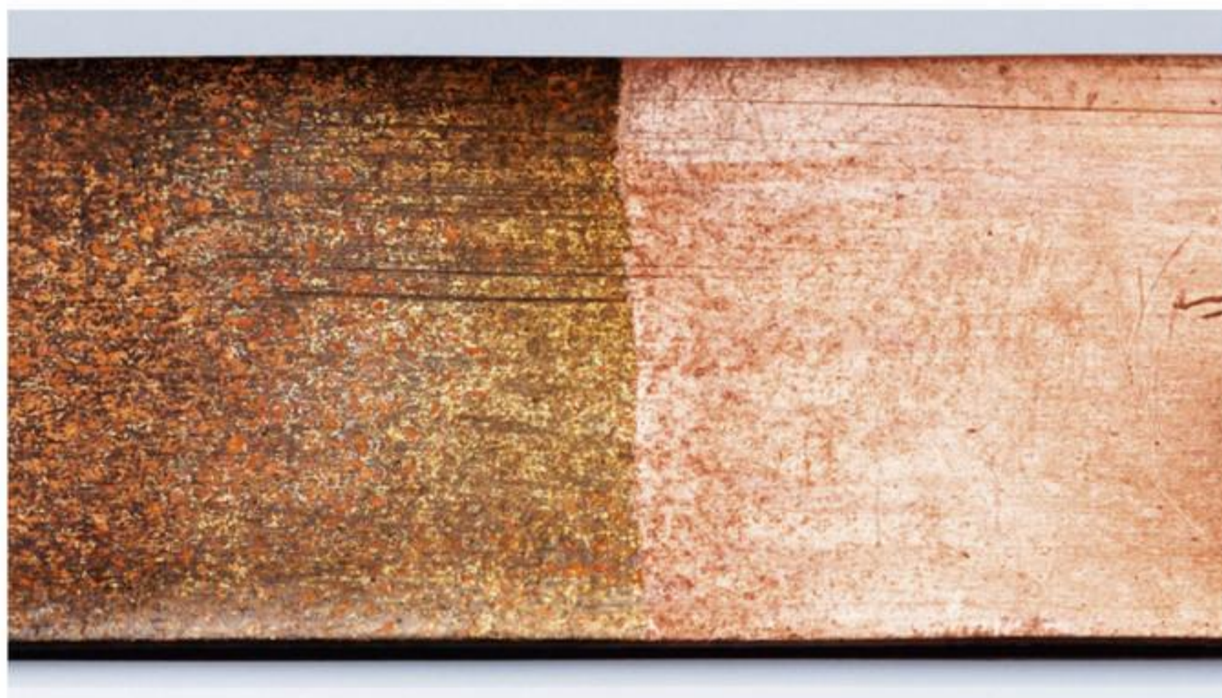
afbeelding 9 Links is het koper verkleurd, rechts niet.
