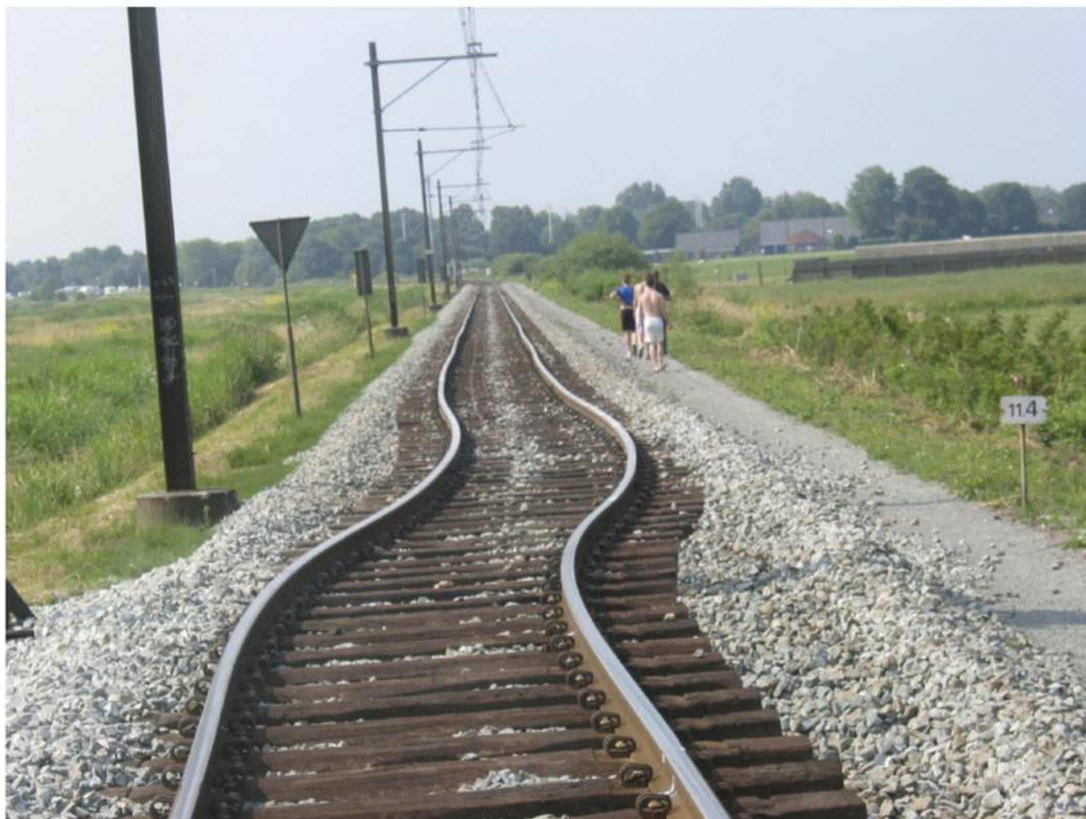
afbeelding 6 Kromtrekken van spoorstaven op een heel hete dag.
