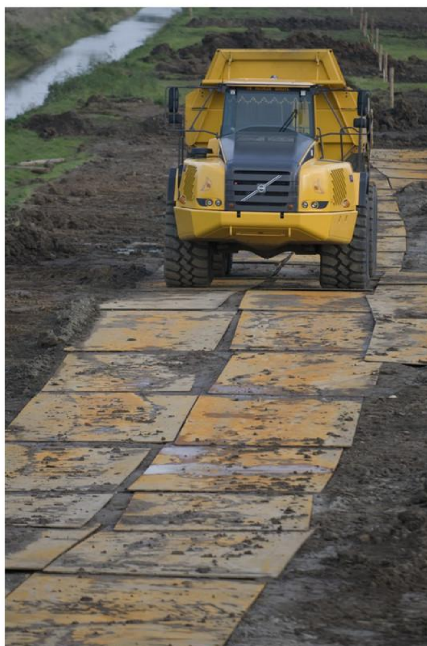
afbeelding 3 Rijplaten verminderen de druk.
